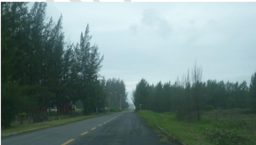
Figura 187. Acesso à ZPE.
