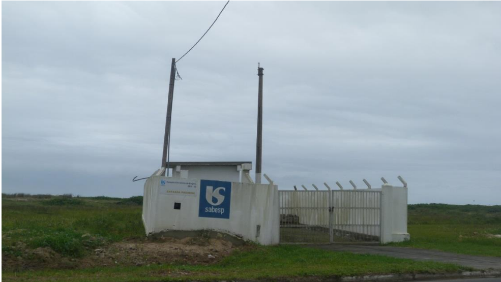
Figura 208. Exemplo de estação elevatória (EEE2 – De Franco).
