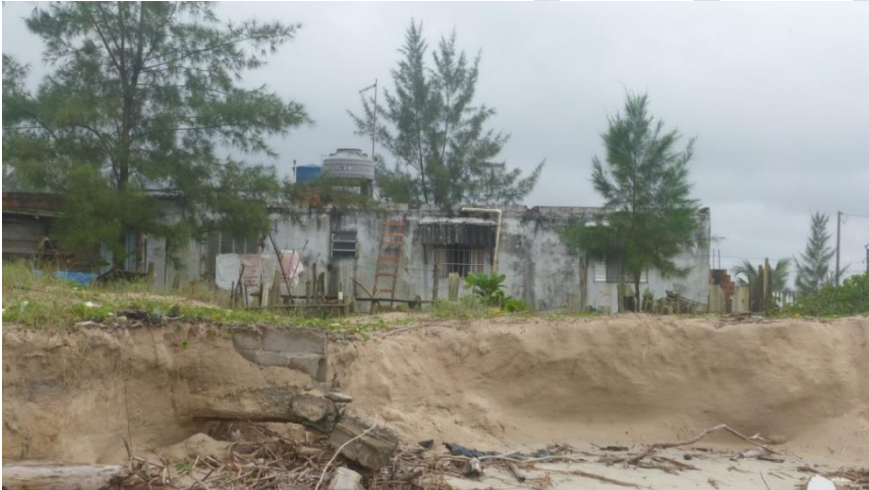
Figura 189. Casa ainda habitada com risco de desabamento pela erosão.
