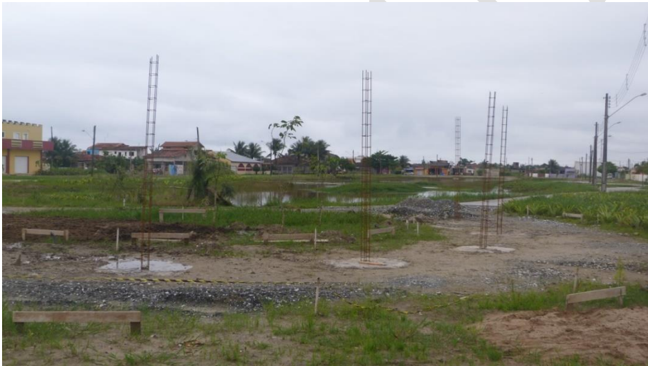
Figura 221. Vista 2 da execução do projeto na Lagoa do Adriana, em dezembro de 2015.
