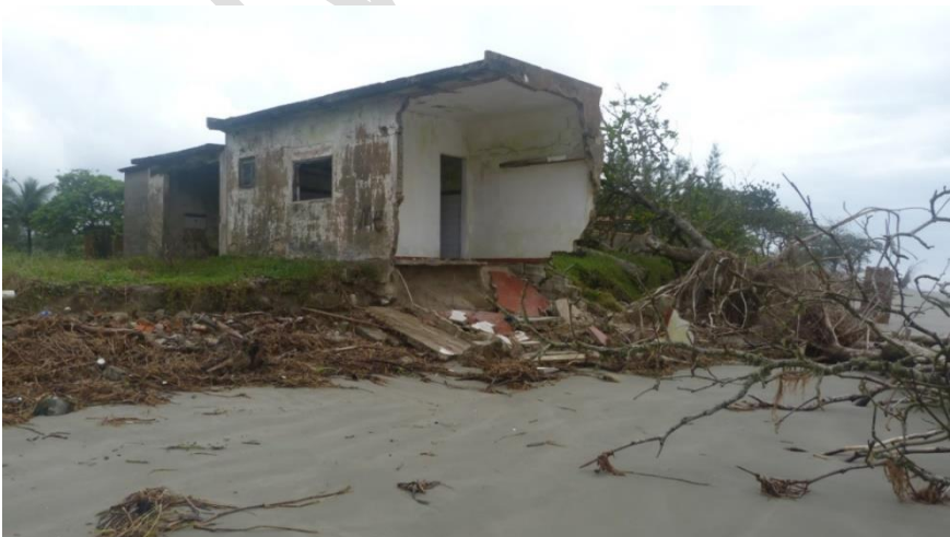
Figura 190. Exemplo de edificação em ruína.
