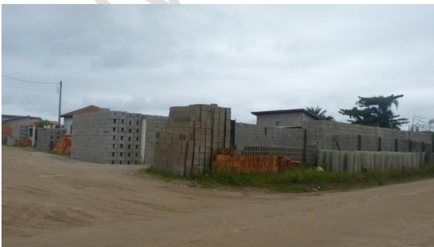
Figura 171. Amplo espaço para venda de material de construção.
