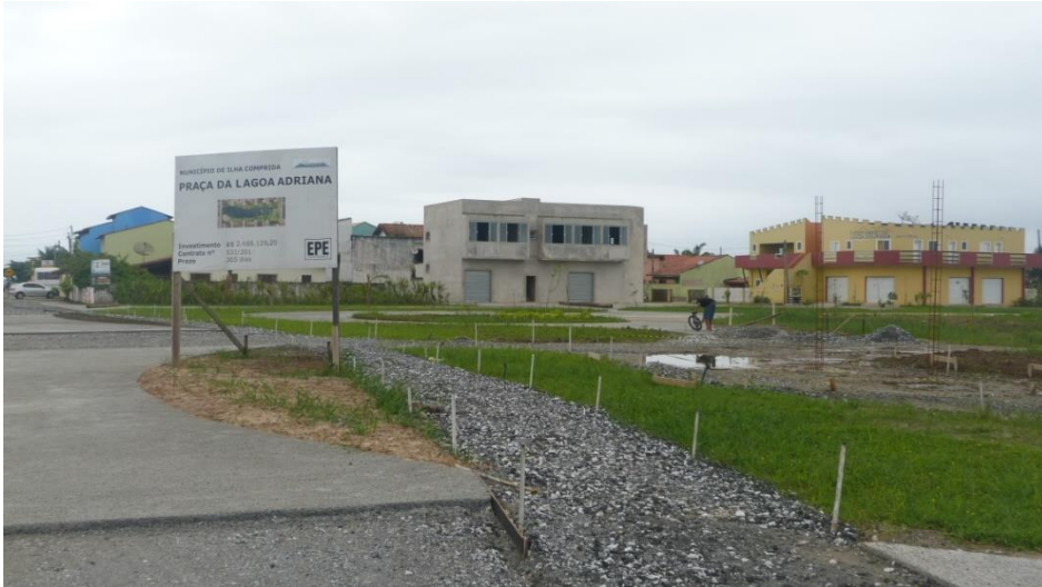
Figura 220. Vista 1 da execução do projeto na Lagoa do Adriana, em dezembro de 2015.
