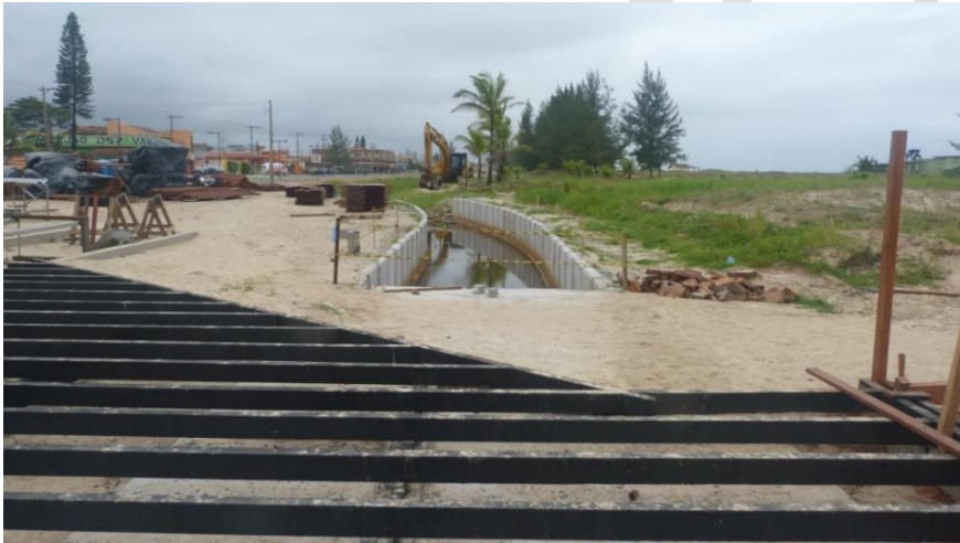
Figura 216. Vista para o canal de drenagem previsto no projeto.
