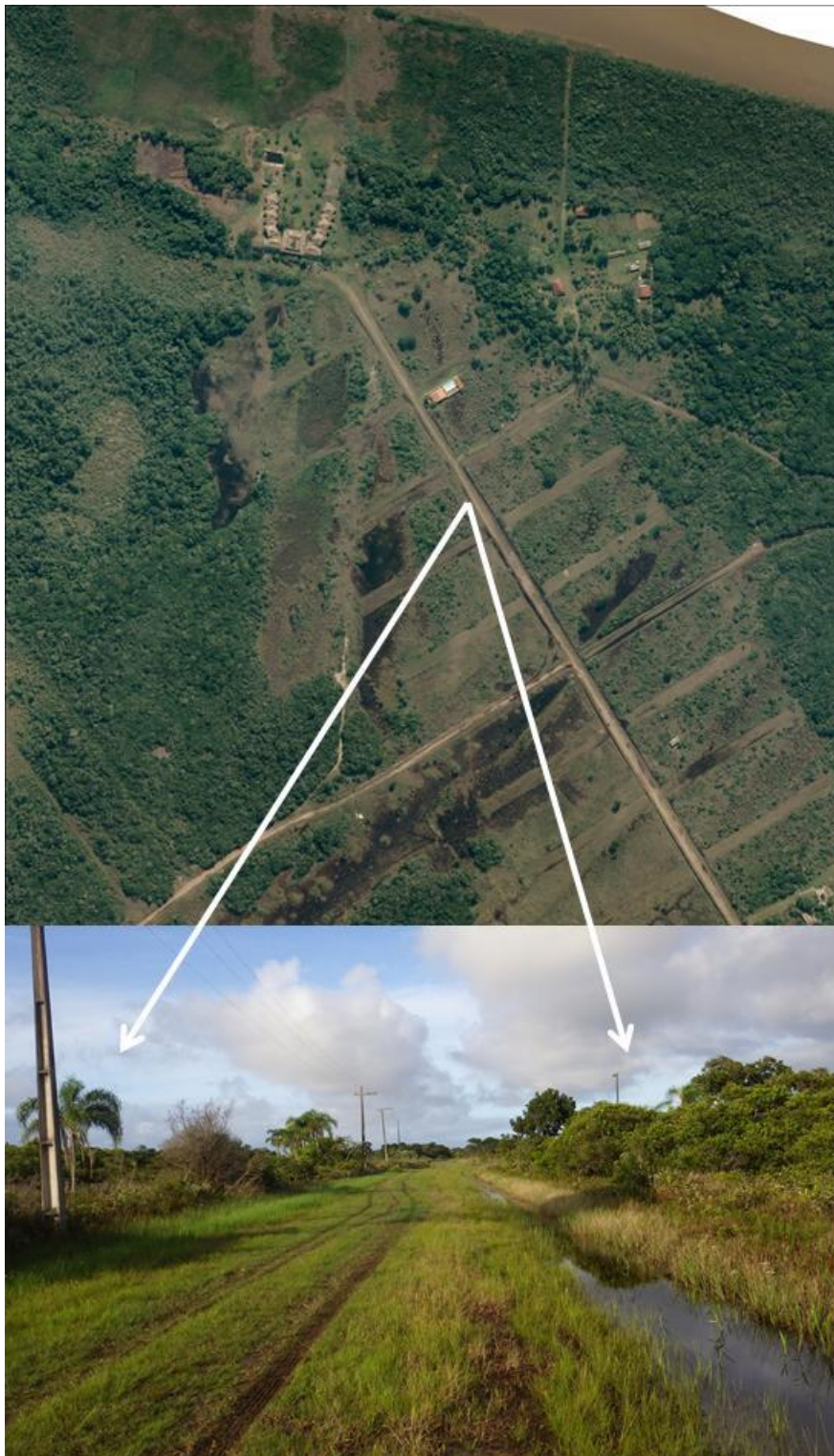
Figura 108. Acesso para o Hotel Maré Alta, região do Boqueirão Norte. Notar o barramento gerado pela abertura da via de acesso (imagem superior) e a vala para o escoamento de água superior aberta ao lado da via (imagem inferior).
