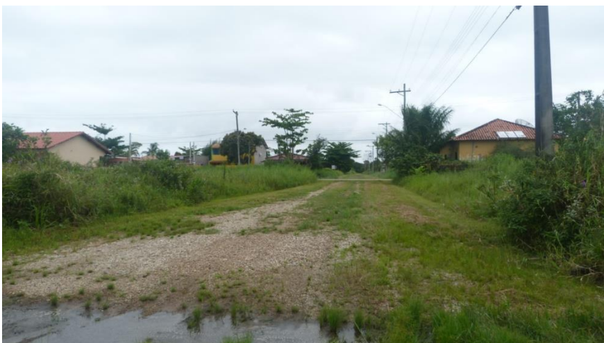
Figura 204. Rua em areia com cascalho e vegetação, apresentando acúmulo de água (ZU 2).
