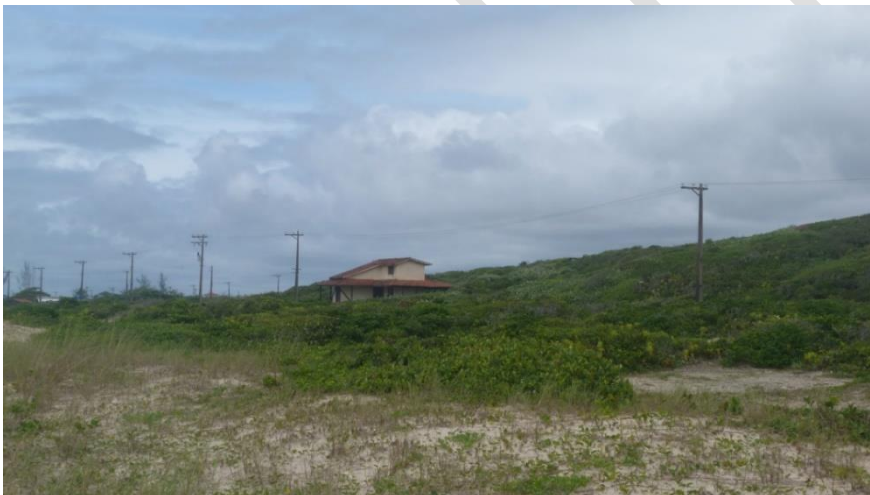
Figura 184. Edificação e linha de energia em meio às dunas.
