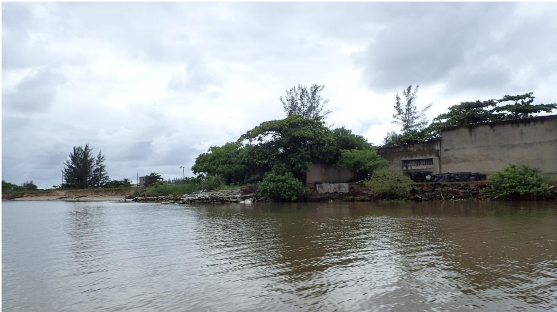
Figura 119. Trecho em erosão tanto na costa (acima) quanto na margem do Mar Pequeno, extremidade NE da ilha.
