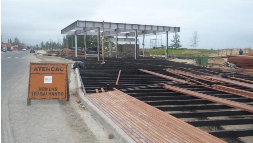
Figura 215. Construção de deck e estrutura central de encontro.
