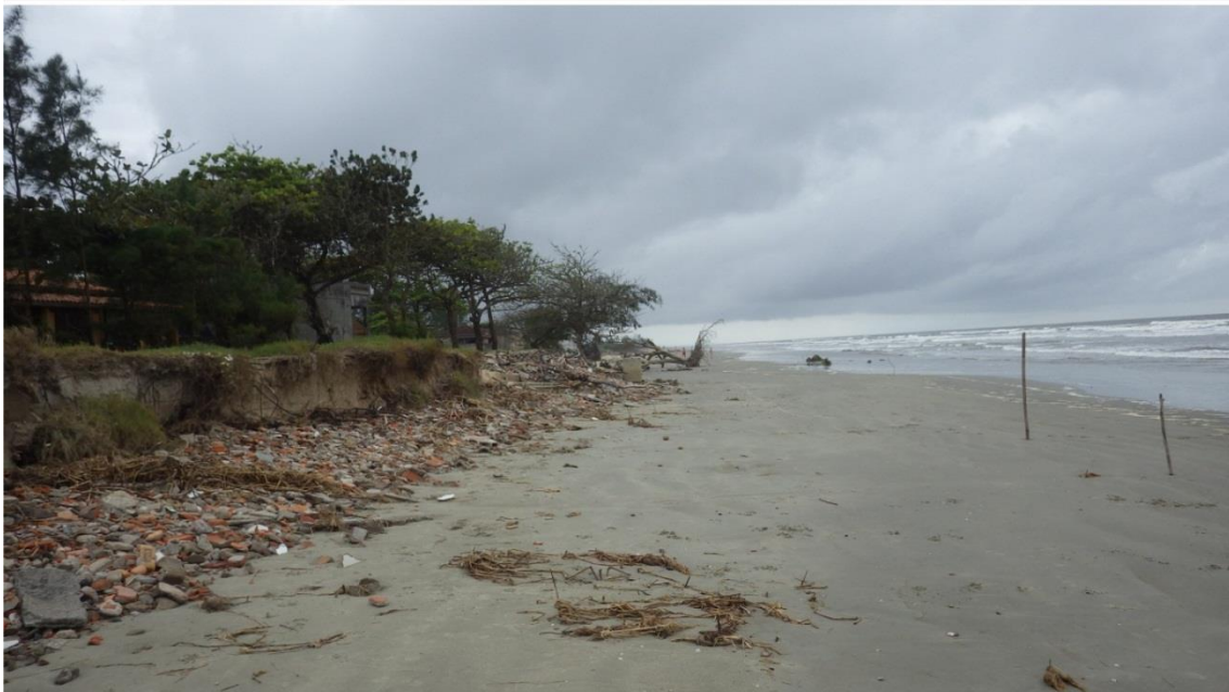
Figura 116. Erosão em dunas frontais e rupturas de deflação na região centro-sul da ilha (imagem superior) e erosão em dunas frontais na porção norte da ilha (imagem inferior).
