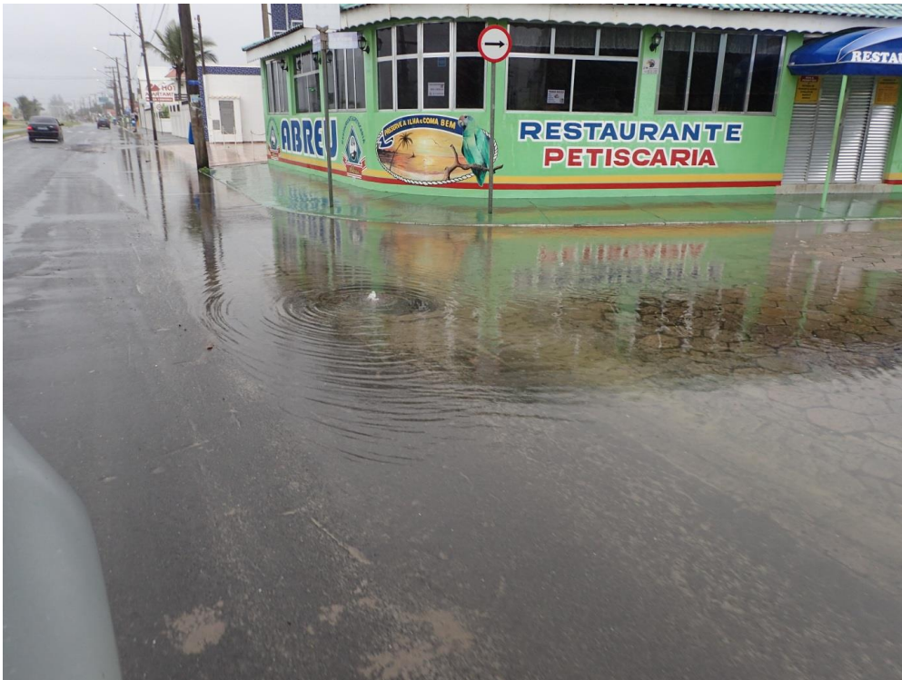
Figura 110. Centro da cidade de Ilha Comprida com áreas de alagamento e retorno de água pluvial em bueiro após chuva moderada.
