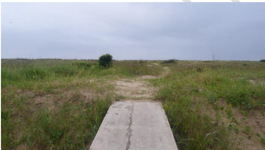
Figura 205. Exemplo de ponte de acesso à praia.
