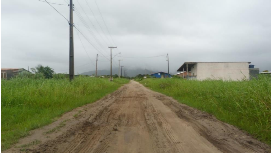
Figura 201. Pavimentação de rua em areia (ZU 1).
