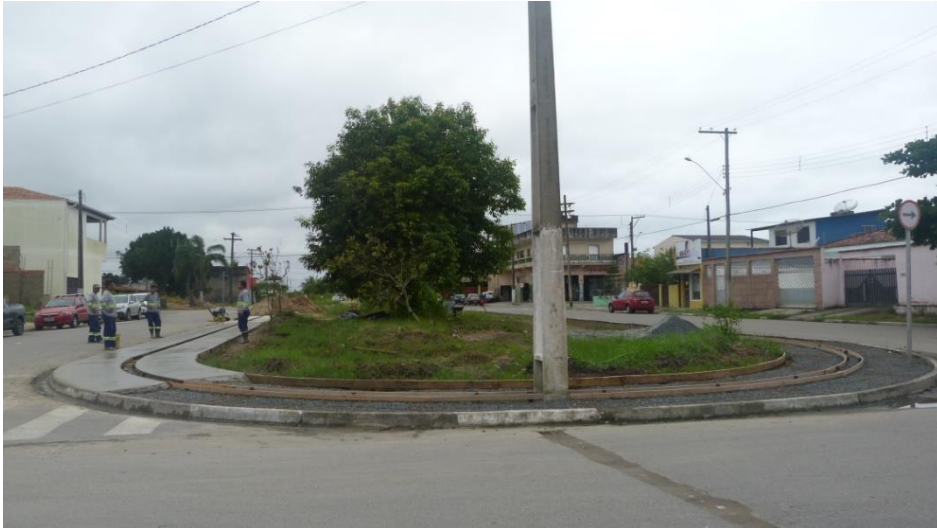
Figura 167. Vias asfaltadas com canteiro central.
